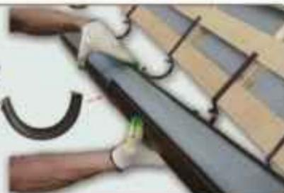
**9** Устанавливаем желоб в крепления и с помощью лепестков закрепляем
