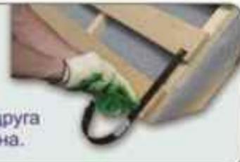
**3** Изогнуть рукой крепление, для горизонтальной установки желоба по линии с учетом уклона
