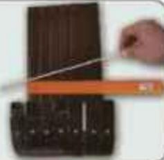
**2** Закрепляем саморезами крепления желобов на расстоянии 400-500 мм друг от друга с учетом линии уклона.
