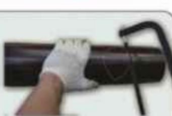
**6** На месте выреза устанавливаем и закрепляем воронку на желоб
