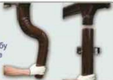
**14** Закрепляем водосточную трубу креплением трубы саморез или лапка
