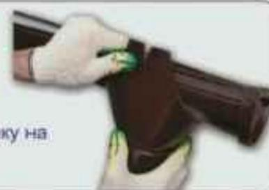
**7** Устанавливаем заглушку желоба и закрепляем саморезом или заклепкой
