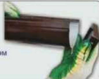
**8** Соединяем между собой желоба в пазы и устанавливаем соединитель желоба
