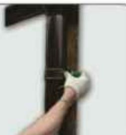
**15** Устанавливаем отмет на трубу на расстоянии 300 мм от земли
