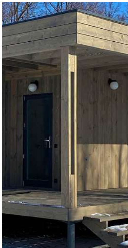
Столбы террасы и верхняя обвязка (у нас одной доской 240 мм), парапетная планка
