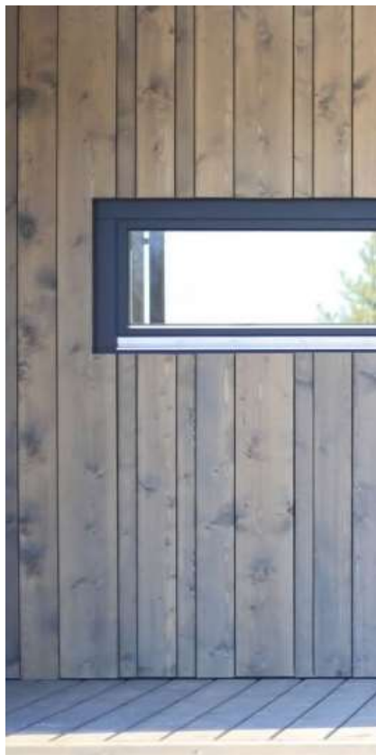
Отделка фасада доской разной ширины
