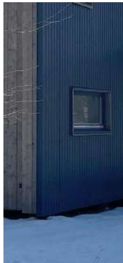
Отделка фасада профнастилом
