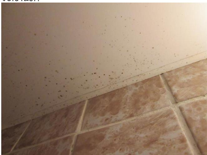
Фото №69. На поверхности натяжного потолка и плитке плесень
