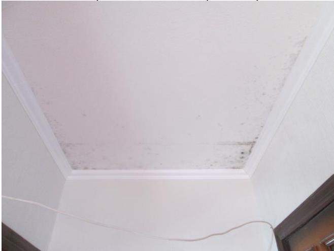
Фото №51. Поверхность потолка и стен поражена грибком
