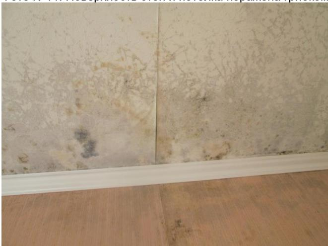
Фото №13. Поверхность стен и потолка поражена грибком
