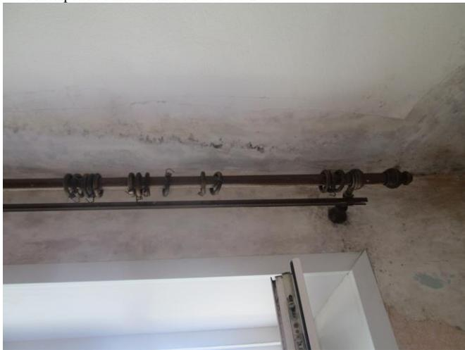
Фото №45. Поверхность стен и потолка поражена грибком
