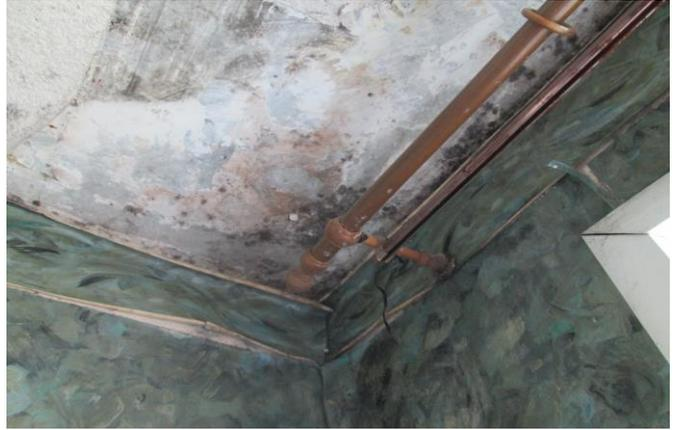
Фото №34. Поверхность стен и потолка поражена грибком
