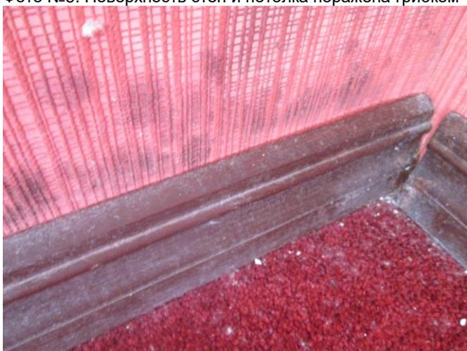
Фото №7. Поверхность стен и потолка поражена грибом
