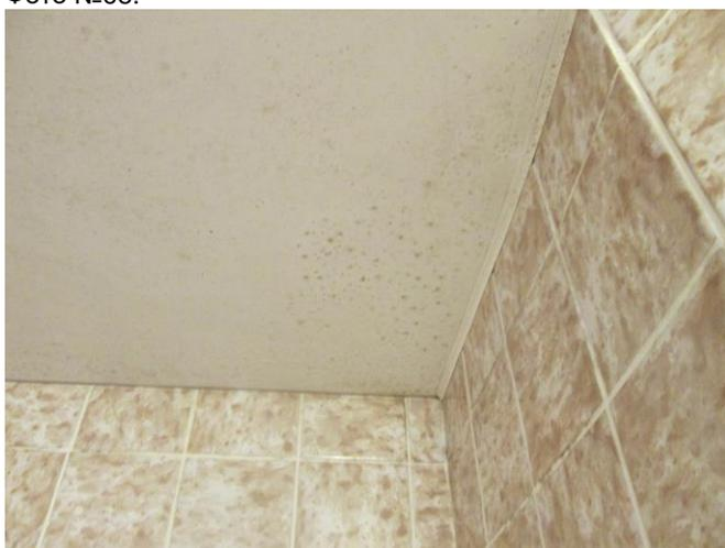
Фото №70. На поверхности натяжного потолка и плитке плесень
