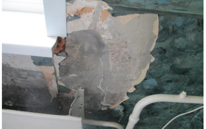
Фото №36. Поверхность стен и потолка поражена грибком
