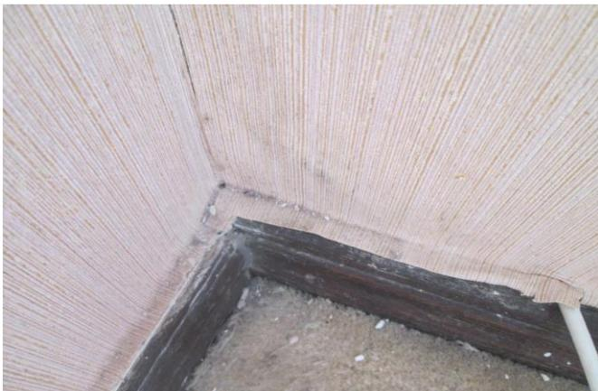
Фото №21. Поверхность стен и потолка поражена грибом
