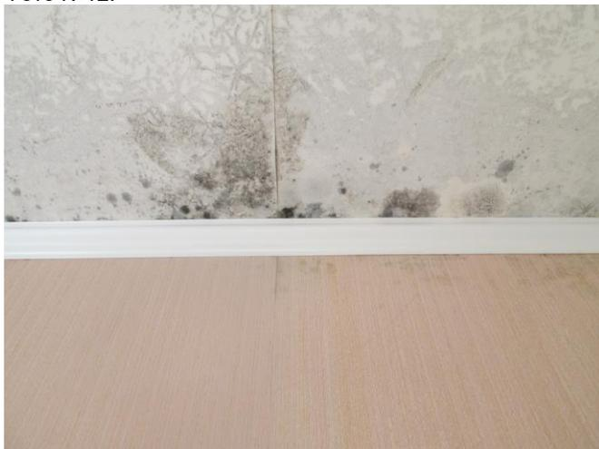
Фото №14. Поверхность стен и потолка поражена грибком
