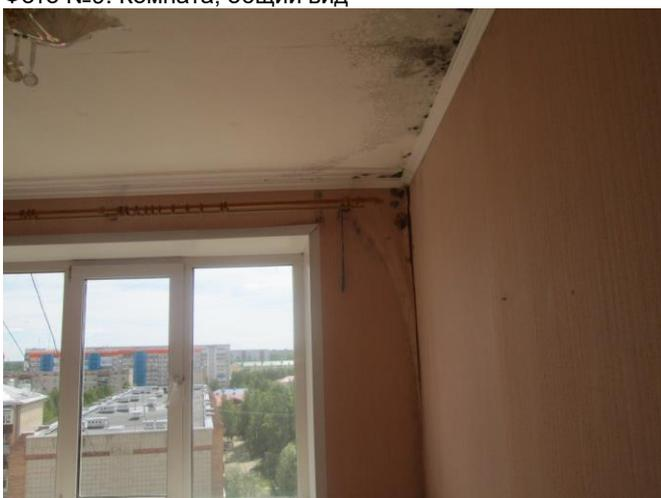
Фото №11. Поверхность стен и потолка поражена грибком
