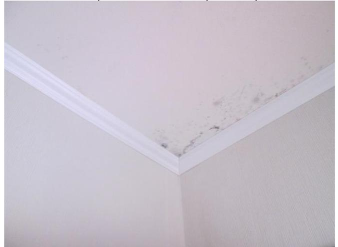
Фото №52. Поверхность потолка и стен поражена грибком
