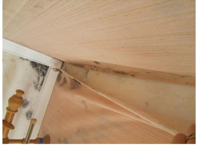
Фото № 16. Поверхность стен и потолка поражена грибом
