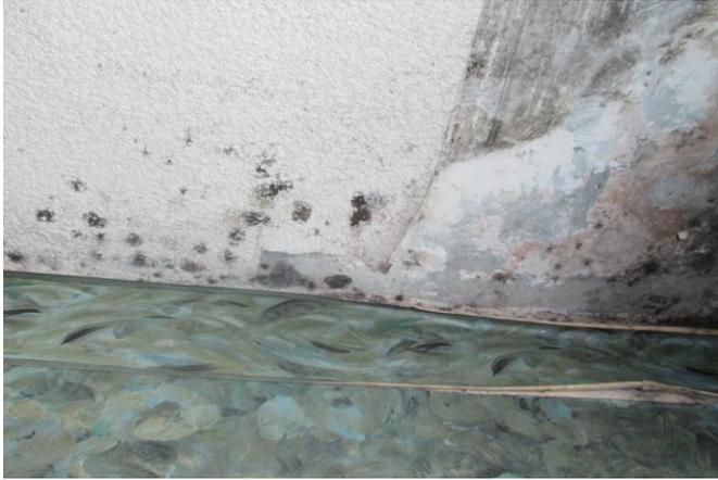
Фото №33. Поверхность стен и потолка поражена грибком
