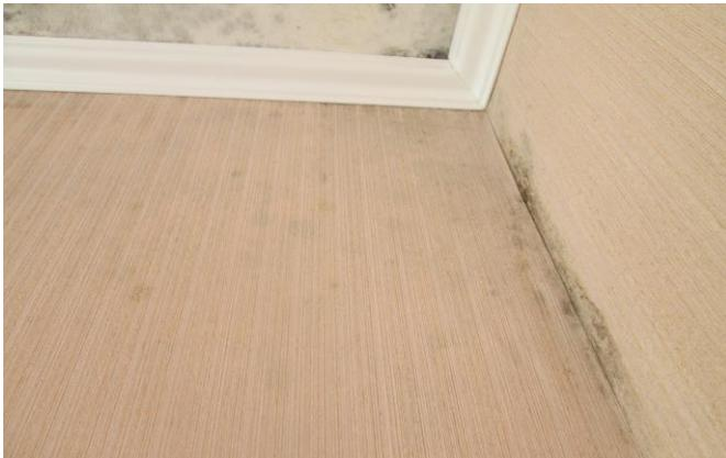
Фото №19. Поверхность стен и потолка поражена грибом
