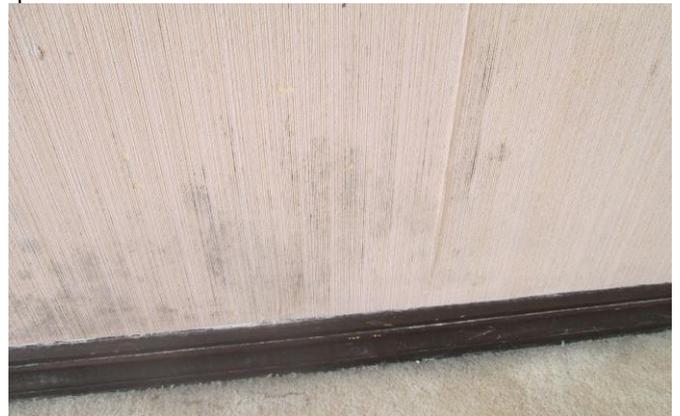
Фото № 18. Поверхность стен и потолка поражена грибом
