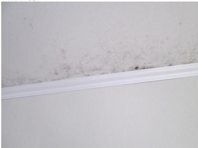
Фото №57. Поверхность потолка и стен поражена грибком
