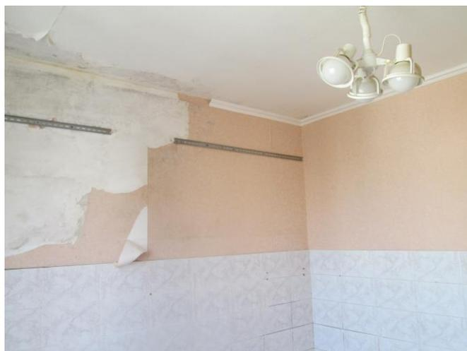
Фото №42. Поверхность стен и потолка поражена грибом
