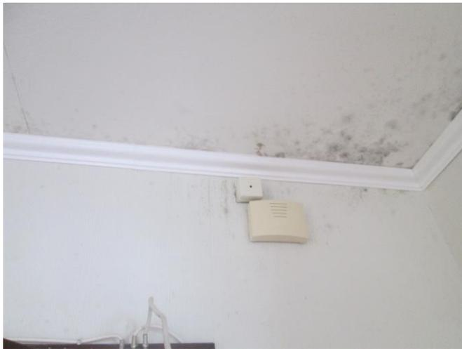
Фото №56. Поверхность потолка и стен поражена грибком
