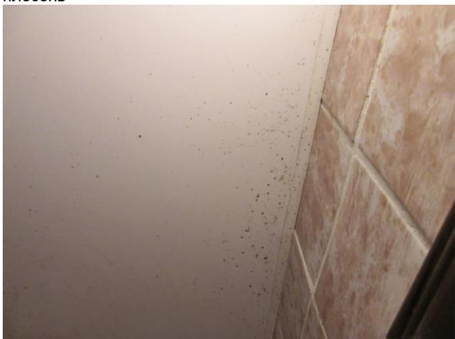
Фото №71. На поверхности натяжного потолка и плитке плесень
