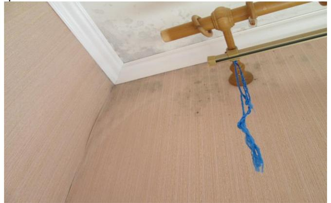
Фото № 20. Поверхность стен и потолка поражена грибом
