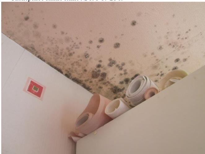
Фото №5. Поверхность стен и потолка поражена грибом
