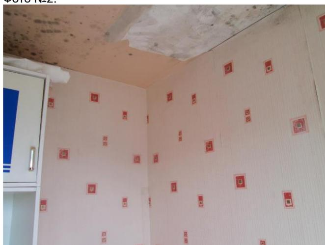
Фото №4. Поверхность стен и потолка поражена грибком
