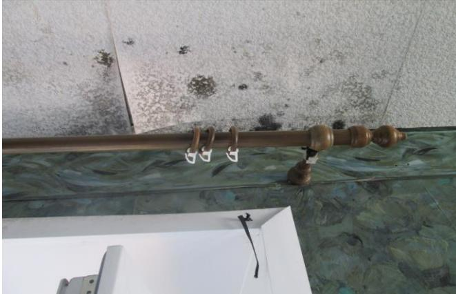
Фото №35. Поверхность стен и потолка поражена грибком
