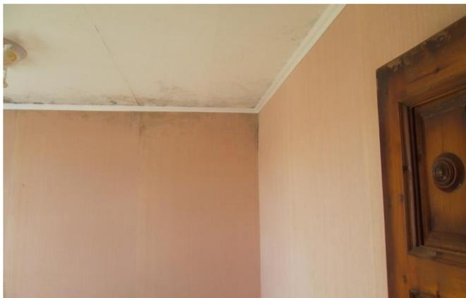
Фото №10. Поверхность стен и потолка поражена грибком
