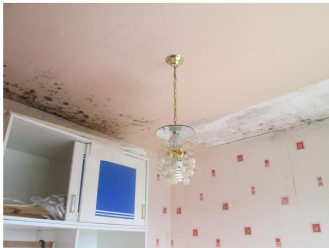
Фото №6. Поверхность стен и потолка поражена грибом
