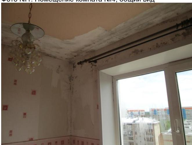
Фото №3. Поверхность стен и потолка поражена грибком
