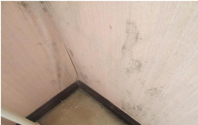
Фото №17. Поверхность стен и потолка поражена грибом
