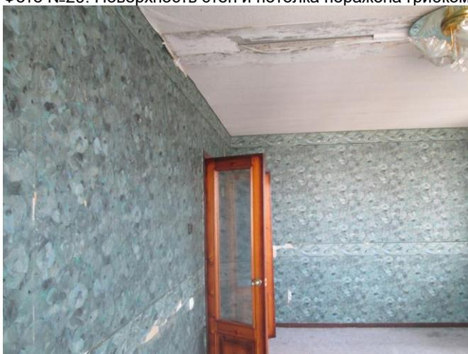
Фото №31. Разрушение шва между плитами перекрытия
