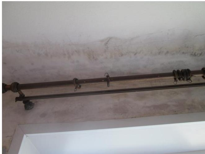
Фото №46. Поверхность стен и потолка поражена грибком
