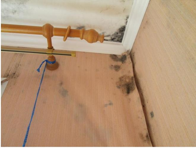
Фото №15. Поверхность стен и потолка поражена грибом
