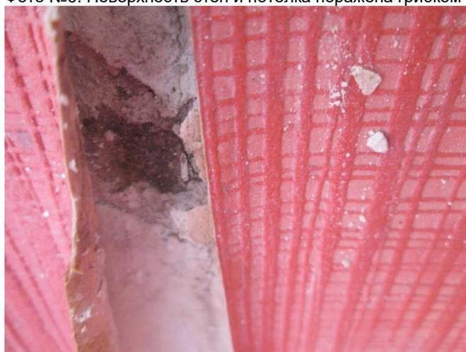
Фото № 8. Разрушение отделочного слоя под обоями
