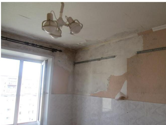
Фото №41. Поверхность стен и потолка поражена грибом
