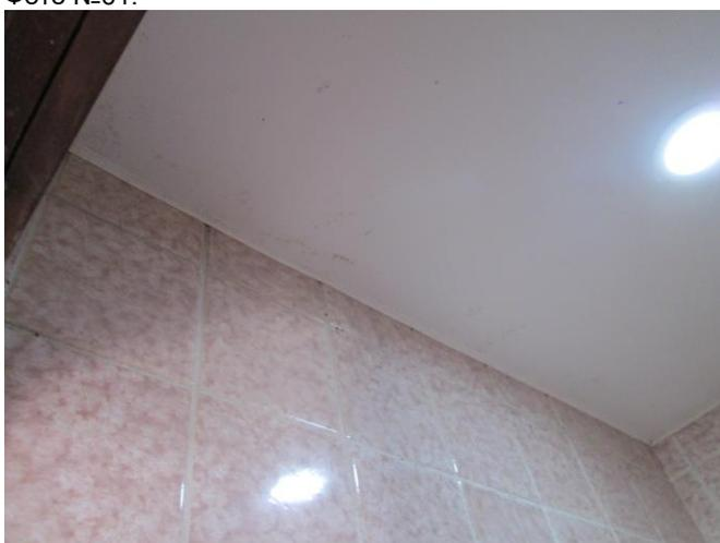
Фото №63. На поверхности натяжного потолка плесень
